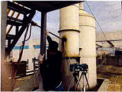
工业废气排放口 2# (FQ-6341023-2)
